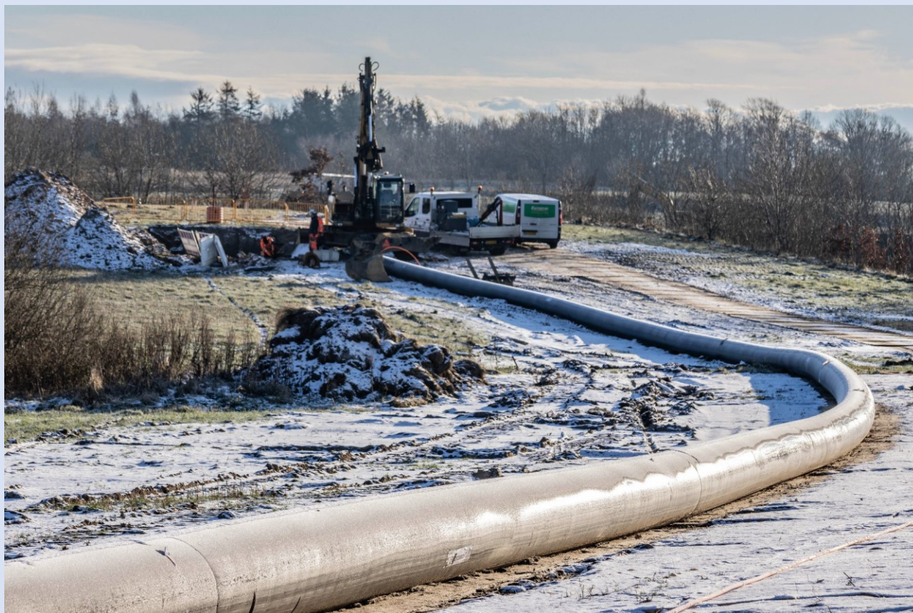
Rørlægningen er i fuld gang mellem Give Fjernvarme og Danpo i Farre. (Foto: Jim Hoff).
